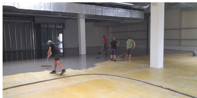
Prodejna HERVIS SPORTS, Praha-Štěrboholy – Nivelační hmota byla čerpána strojem Duo mix 2000 pro urychlení prací i v malém počtu pracovníků
