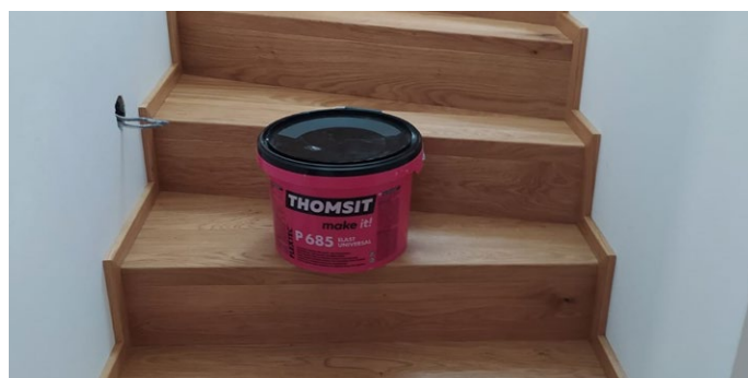
Soukromý objekt – Lepení dřevěné masivní krytiny na zatočených schodech, na cementový podklad
